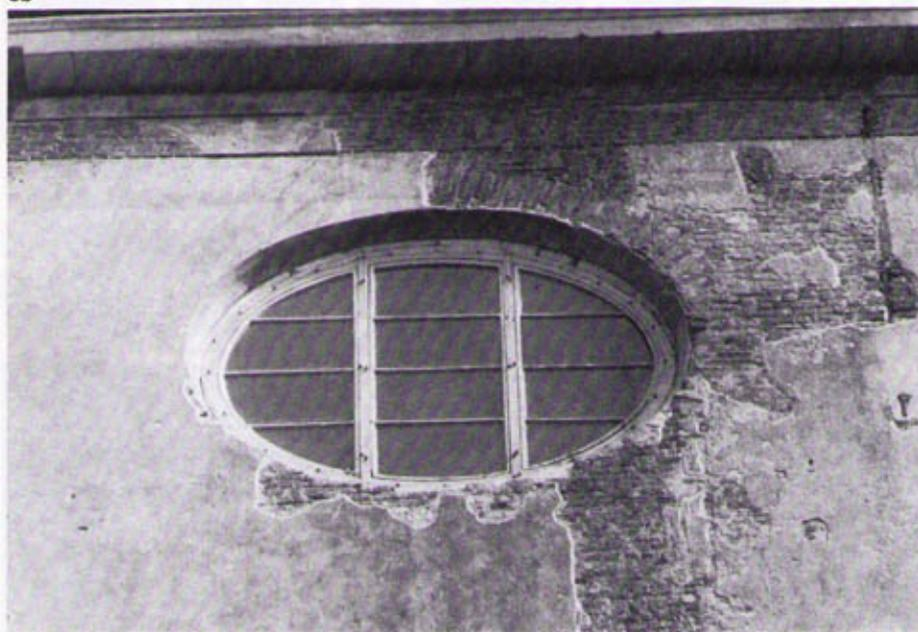
3a.b. Milano, Palazzo della Ragione, insieme e dettaglio della facciata esterna dopo l'intervento conservativo. La problematica del mantenimento delle tracce di materia (sia essa intonaco, cotto o pietra) prevale ancora una volta sulla necessità di rendere omogeneo (o di rimuovere in base a ipotesi tratte dal gusto) il paramento esterno.
